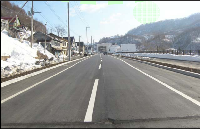
工事完成写真
